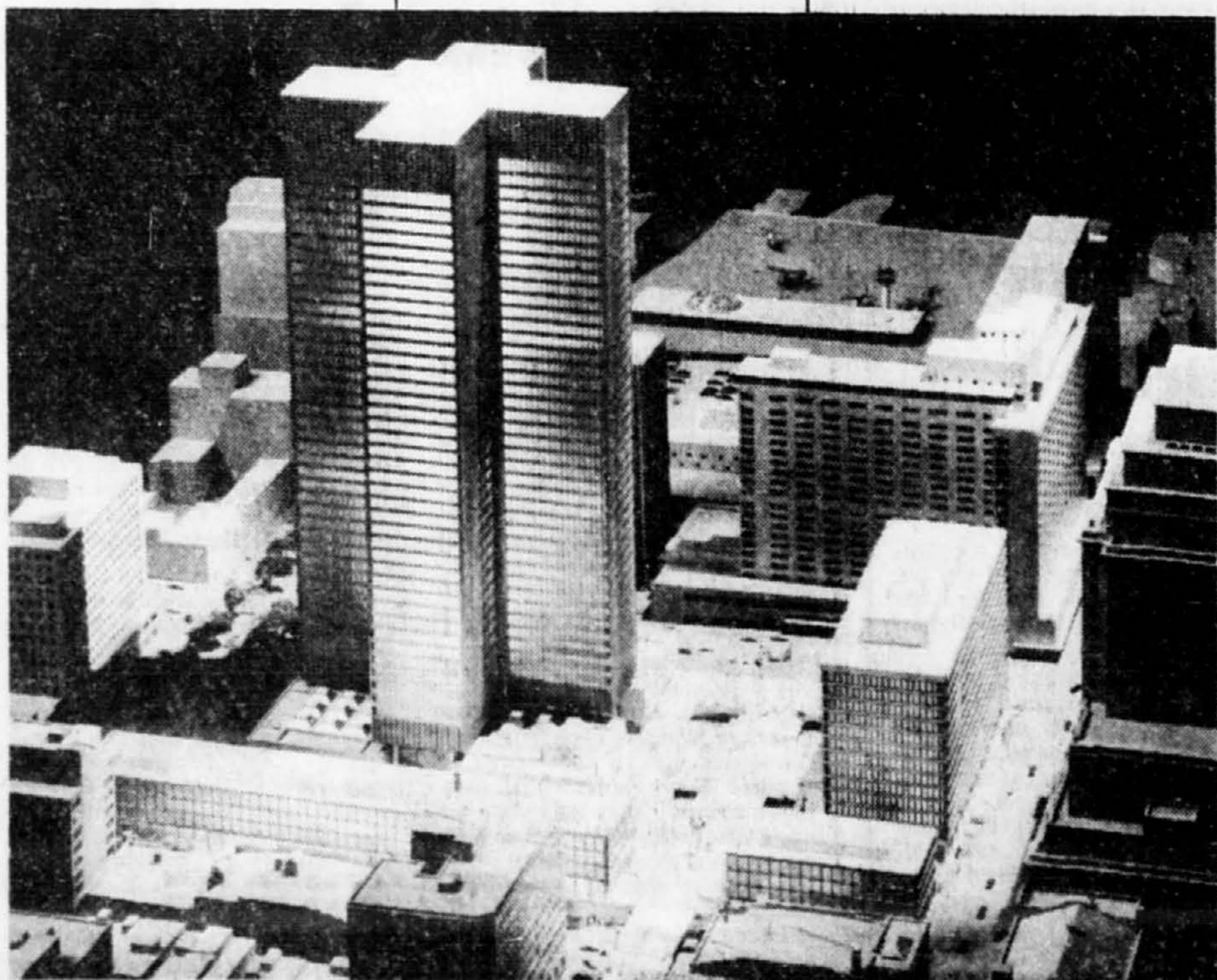
Dans son édition du 26 mars 1958, LA PRESSE annonçait à ses lecteurs l'adjudication par Webb and Knapp du contrat de construction de la place Ville-Marie à la société Foundation Company of Canada Limited, au coût de $60 millions. Et l'article était accompagné de la photo ci-dessus.
